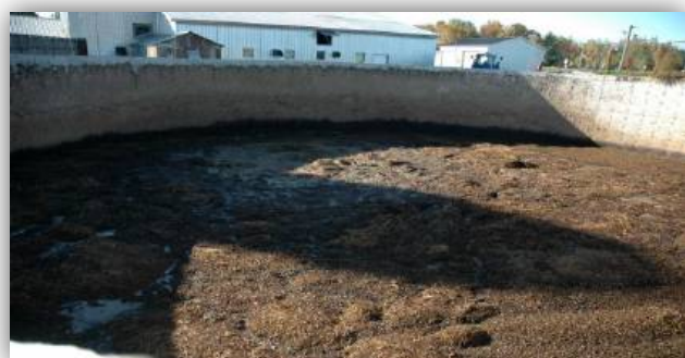
Gülesilo des Betriebs
